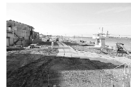
▲長塚町付近にて進んでいる道路工事
