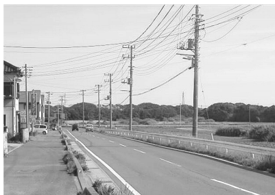
▲道路灯設置予定場所付近 (セブンイレブン先)
