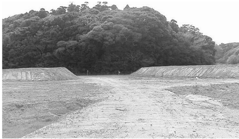
▲地盤改良工事が終了し、盛土した磯見川付近
