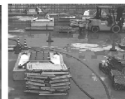
免震装置設置状況
